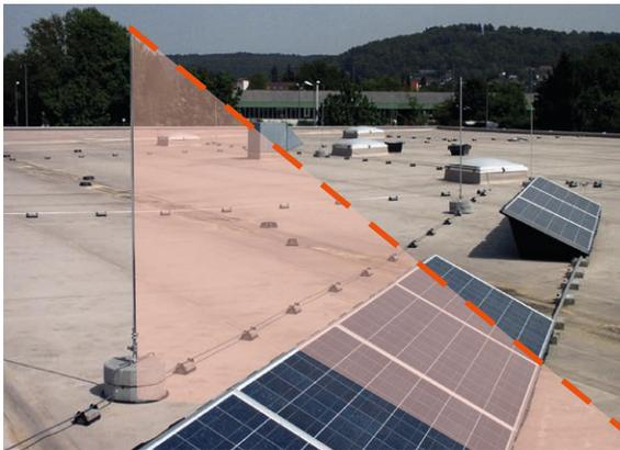
Bild 14 Ermittlung des Schutzraumes mittels Schutzwinkelverfahren
