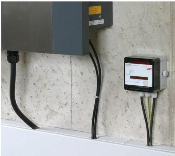
Bild 16 Typ 2-Ableiter DEHNcube YPV SCI 1000 1M zum Schutz von Wechselrichtern (1 MPPT)
