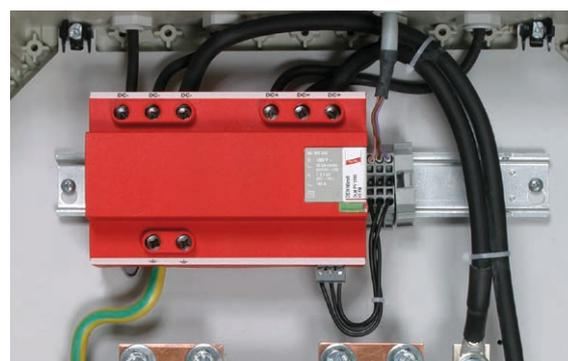
Bild 8 Kombi-Ableiter Typ 1 auf Funkenstreckenbasis DEHNlimit PV 1000 V2
